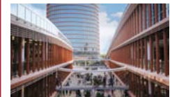
Torre Sevilla Sevilla
