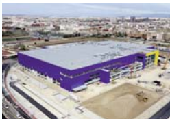
Ikea (en construcción) Alfafar, Valencia
